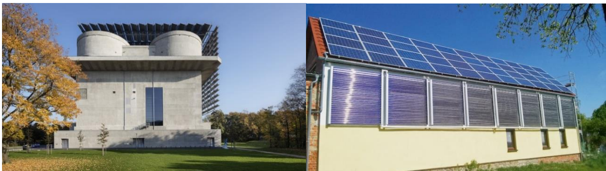
Abbildung 17: Solaranlagen an Fassade mit geneigten (links) und senkrechten (rechts) Modulen (Quelle: Hamburg Energie (o.J.) und Bauen & Wohnen Aktuell (2016))
