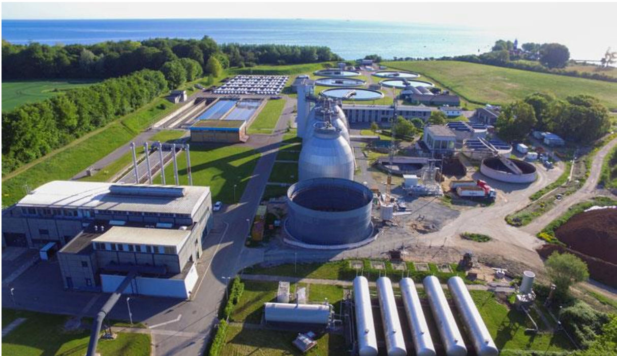
Abbildung 13: Kläranlage aus der Vogelperspektive, Quelle: https://www.kiel.de/de/umwelt_verkehr/klimaschutz/verwaltung/klaerwerk.php
