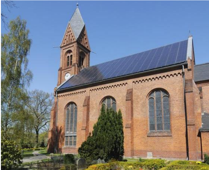
Abbildung 15: PV-Anlage auf dem Dach einer denkmalgeschützten Kirche (Quelle: Solaranlage.eu (o.J.))
